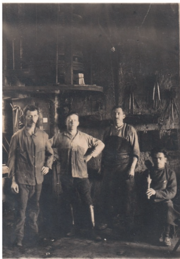
Pohled do kovárny v Kuníně (Jan Bašný v kovářské zástěře)
